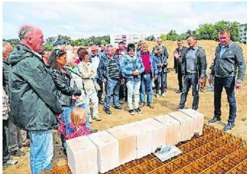
Baubeginn in Knieper Nord.
